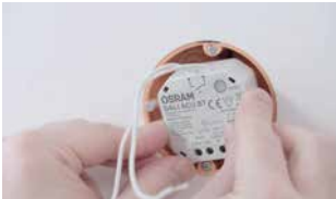
02 Coloca el DALI ACU BT en la caja del mecanismo.
