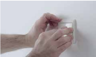
04 Coloca la carcasa del pulsador.
